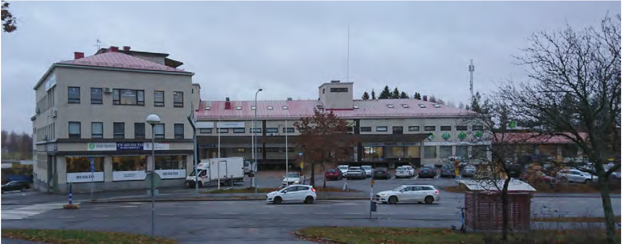
Hankkijan entinen varasto- ja konttorirakennus luoteesta. Porrassalmenkatu on kuvan etualalla.
